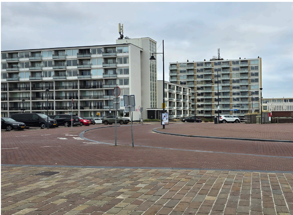
BOSCHFLAT EN GOLFFLAT GEZIEN VANAF DE STRANDZIJD
